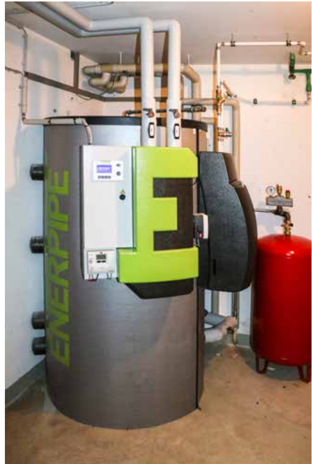
Abb. 1: Installiertes Pufferspeichersystem
