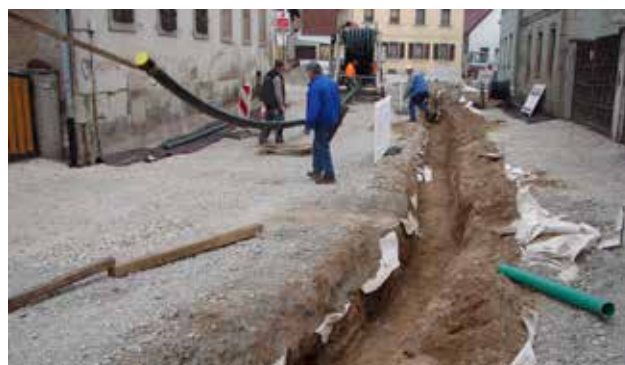
Abb. 30: Offener Rohrgraben und Abwickelvorrichtung
