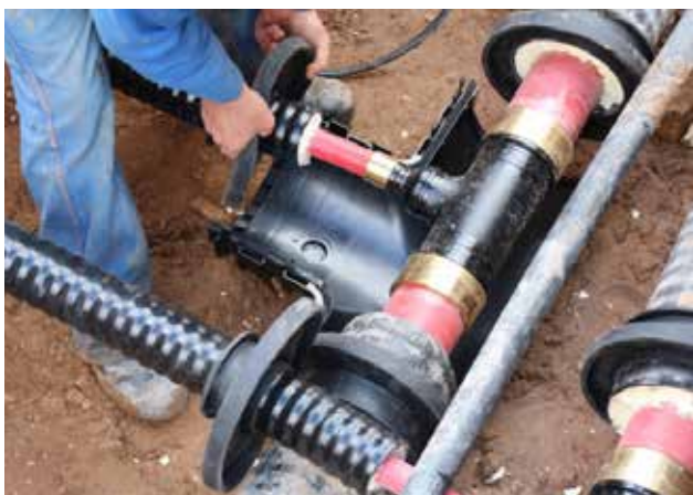
Abb. 4: Montage CaldoCLICK Muffe im Bestand (Muffendichtgummi)
