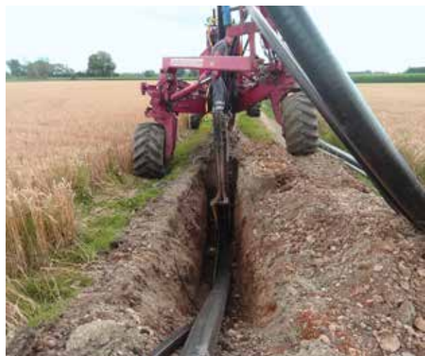
Abb. 27: Pflugverlegung
