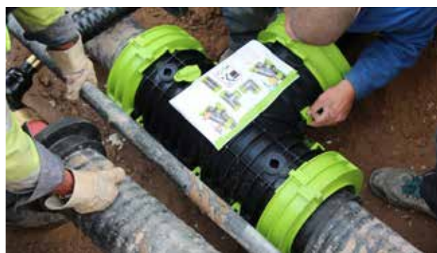
Abb. 5: Montage CaldoCLICK Muffe im Bestand (Einsteckclip)
