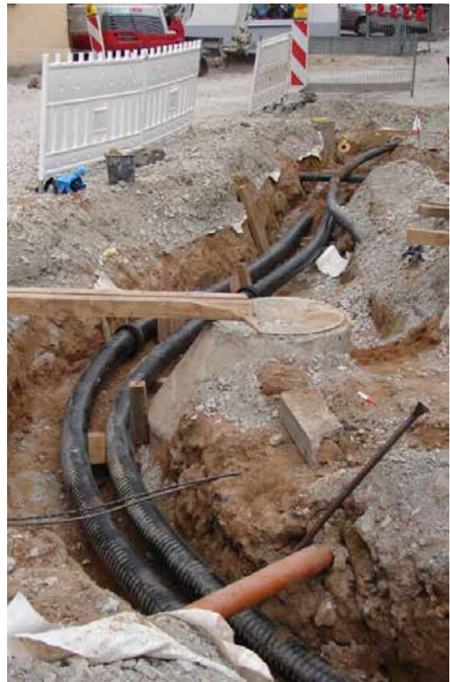
Abb. 2: Verlegung in der Praxis
