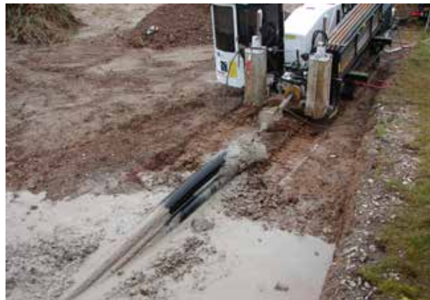
Abb. 29: Spülbohrgerät mit Rohren in der Startgrube
