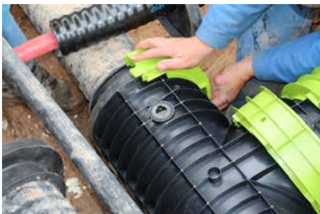
Abb. 3: Montage CaldoCLICK Muffe im Bestand (Verschlussring)
