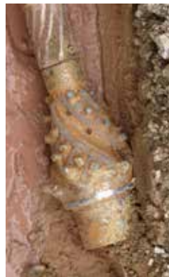
Grabenloses Verlegen der Rohre bei Hindernissen
