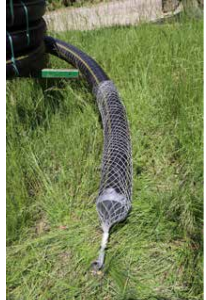
Grabenloses Verlegen der Rohre bei Hindernissen
