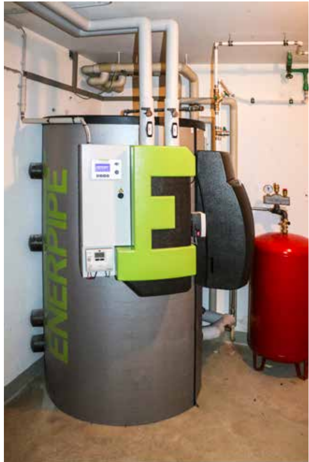
Abb. 1: Installiertes Pufferspeichersystem
