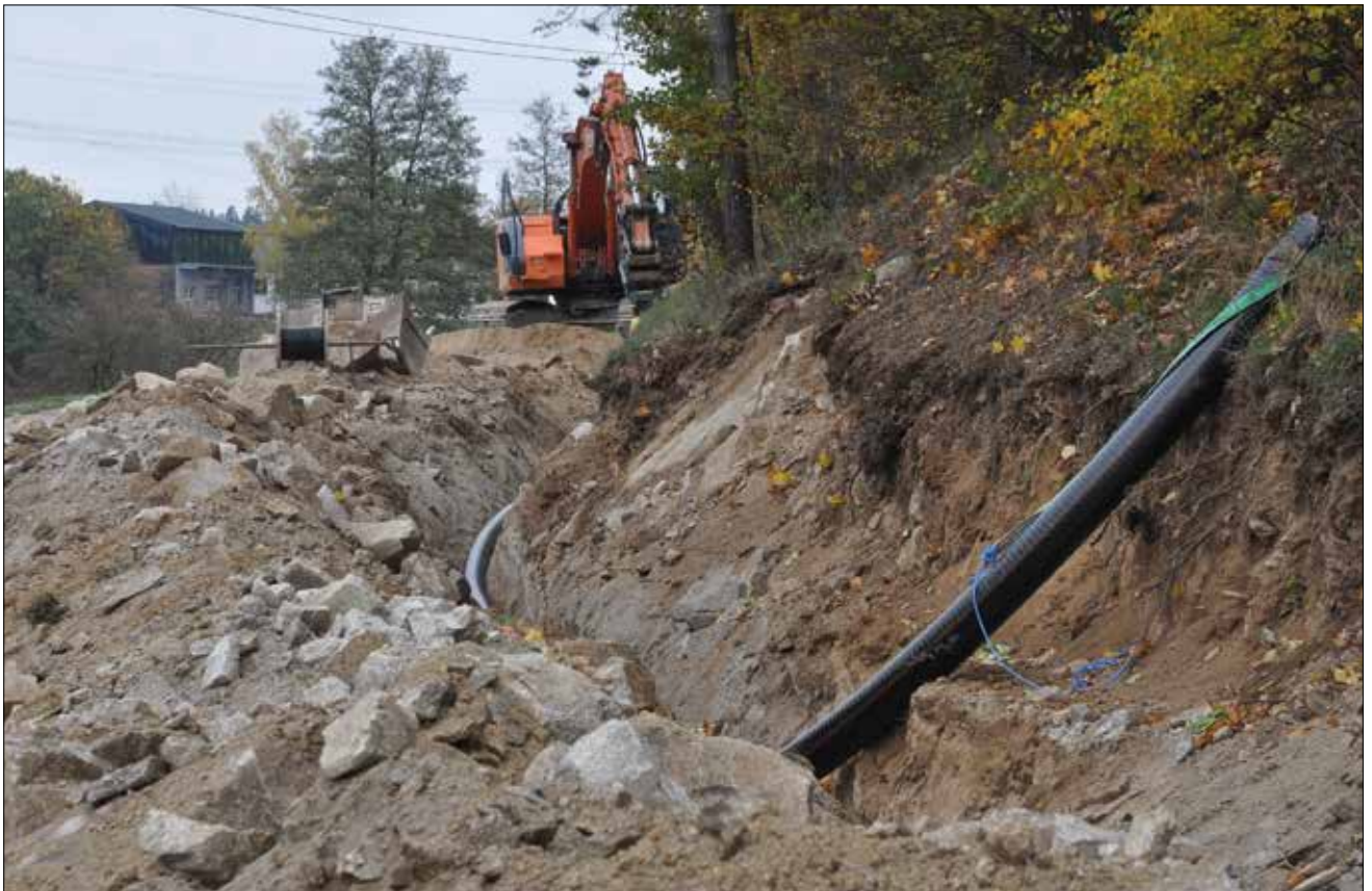
Bild 1. Flexibles Rohrsystem Fibrelex Pro 90+90/225 in der Praxis
