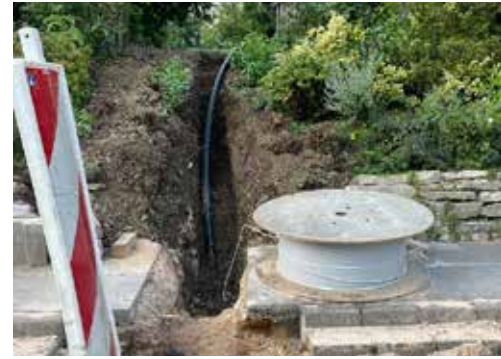
Hausanschluss einer Wärmeleitung: In den allermeisten Fällen werden mit den Rohrleitungen für das Wärmenetz auch gleich Glasfaserkabel verlegt, in diesem Fall das graue Kabel. Dadurch erhalten die Dörfer schnelles Internet, ohne dass die Straßen ein weiteres Mal aufgerissen werden müssen. Foto: Nahwärme Ettenstatt eG
